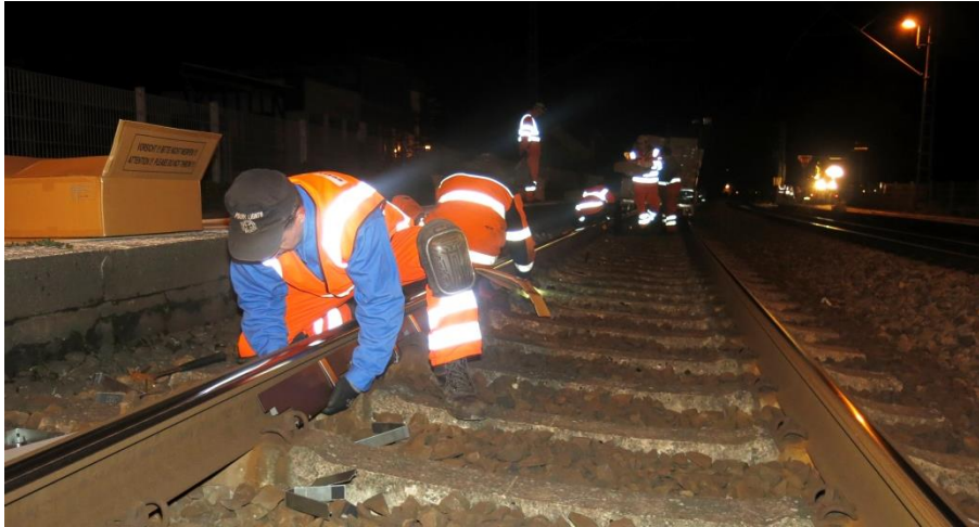
Grafik 2. Installation von Calmoon Rail auf einem deutschen Gleisabschnitt
