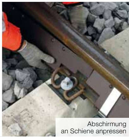
Einbau Klippbefestigung
