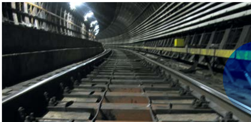
Wiener Linien | FFU Kunstholzschwelle in Tunnel in Gummischuh gelagert
