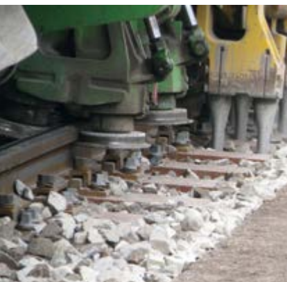
Stopfen Flachschwelle mit Stopfzug
