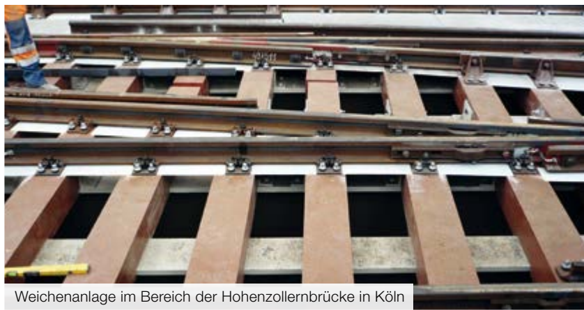
Speziallagerung FFU Kunstholz auf offenem Stahltragwerk
