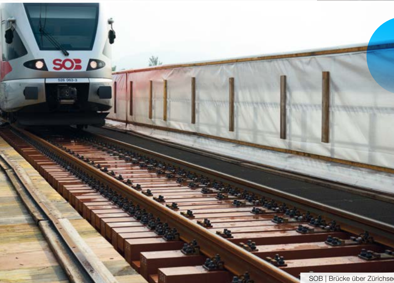
Speziallagerung FFU Kunstholz auf offenem Stahltragwerk
