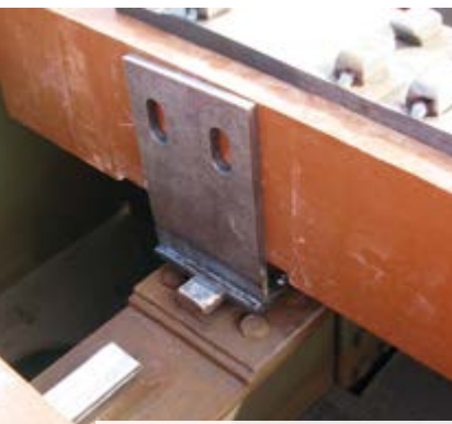
Speziallagerung FFU Kunstholz auf offenem Stahltragwerk
