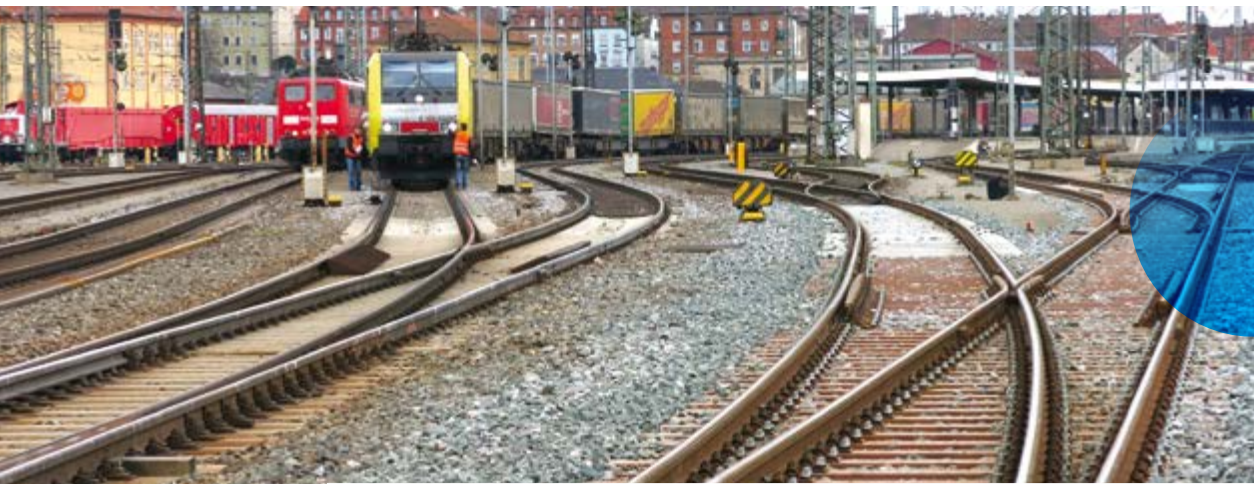
DB AG | Würzburg | 70.000 Lasttonnen je Tag | 2012 eingebaut | bis 2018 Schwelle wartungsfrei
