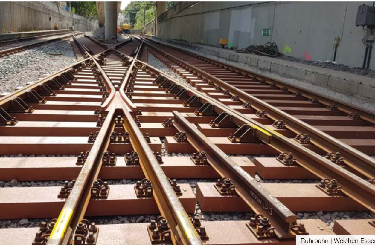
DB AG | Würzburg | 70.000 Lasttonnen je Tag | 2012 eingebaut | bis 2018 Schwelle wartungsfrei
