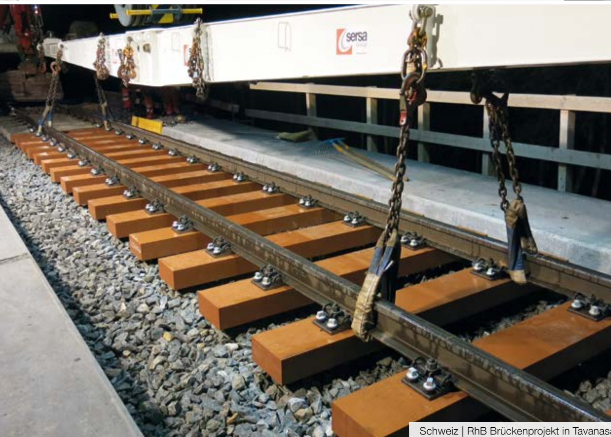
Stopfen Flachschwelle mit Stopfzug
